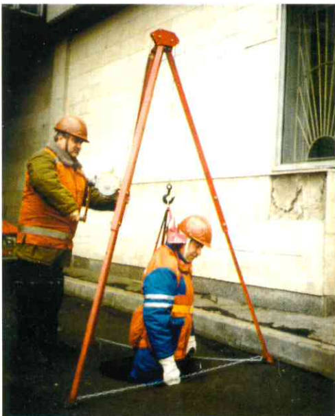
После выставки в Дюссельдорфе: испытание нового приспособления для обеспечения безопасности труда ( ГП „МОСГАЗ“ )
